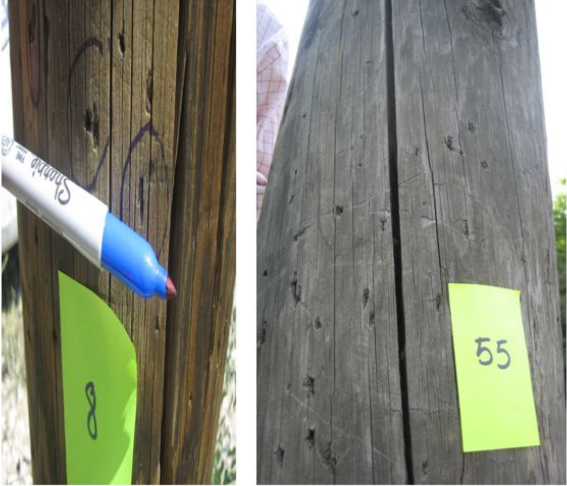
Şekil 11. Artvin-Pamukçular ve Murgul yöresinde yoğun bir şekilde böcek tahribatına uğramış tel direği
