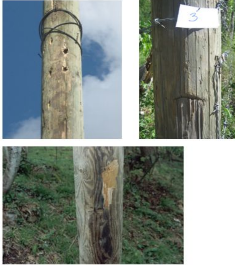
Şekil 13. Artvin-Pamukçular ve Murgul yöresindeki tel direklerinde tespit edilen insanların neden olduğu kusurlar
