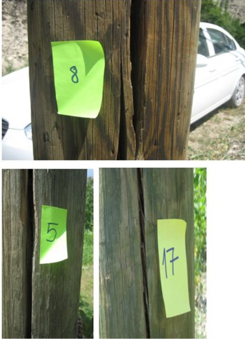
Şekil 12. Artvin-Pamukçular ve Murgul yöresindeki tel direklerinde tespit edilen çatlak ve yarıklar
